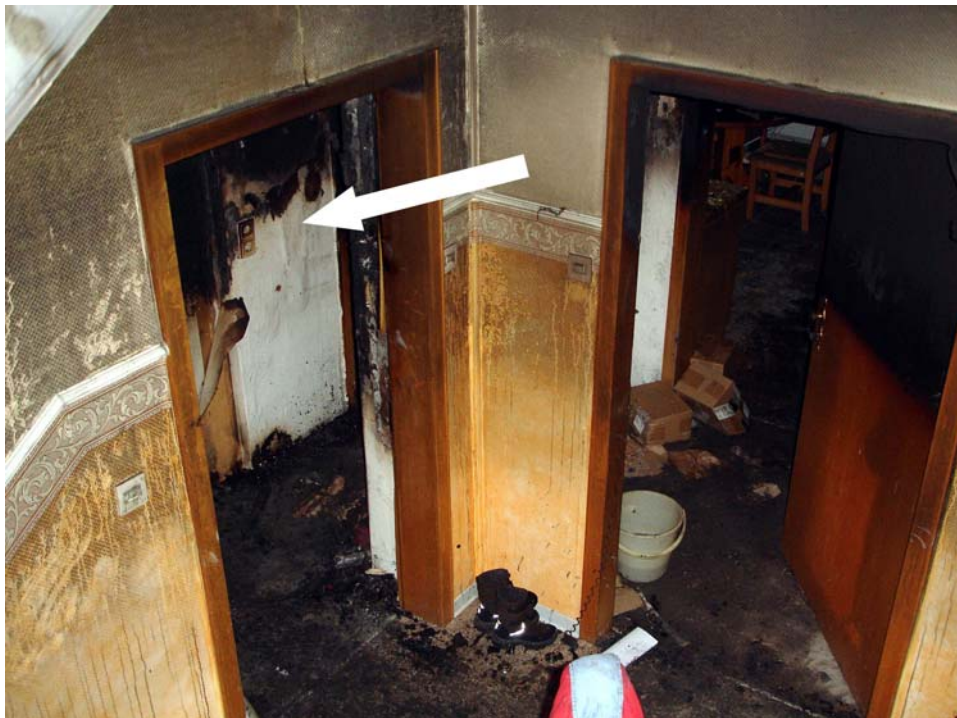
Der weiße Pfeil markiert die Wohnungstür im Erdgeschoss, in welche der mobile Rauchverschluss eingebaut war. Beide Wohnungstüren waren geschlossen. (Foto: Einsatzdokumentation FF Bad Harzburg).
